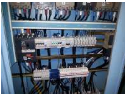
Mises aux normes électriques
